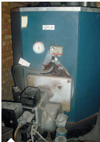
Naprawa pieca do ciepłej wody
