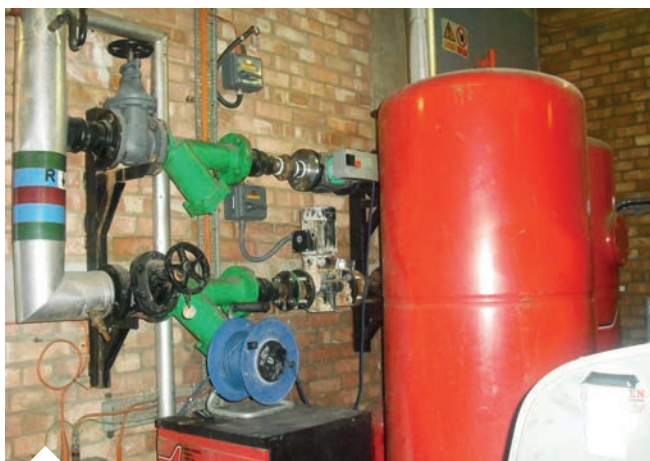
Wymiana zbiorników ciśnieniowych
