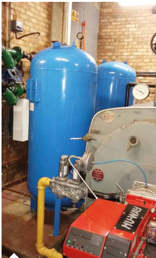
Dwa zbiorniki ciśnieniowe ostatnio wymienione w kotłowni.
