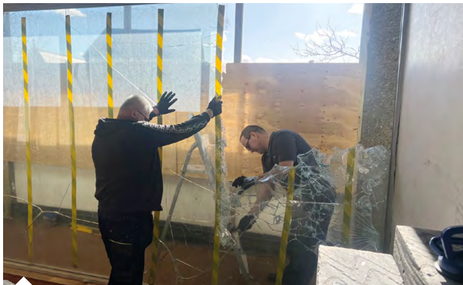
Wymiana pękniętego okna w Sali Malinowej
